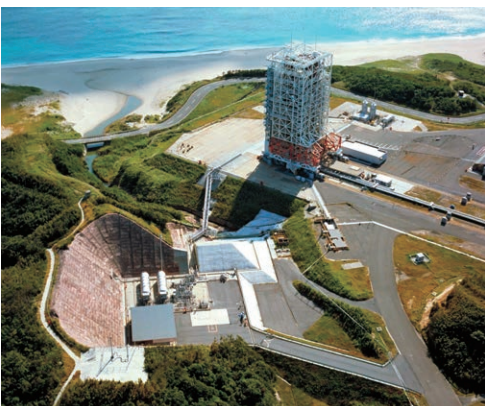
発射場の奥に見える2本の円筒型のタンクが液体水素貯蔵設備(※)
