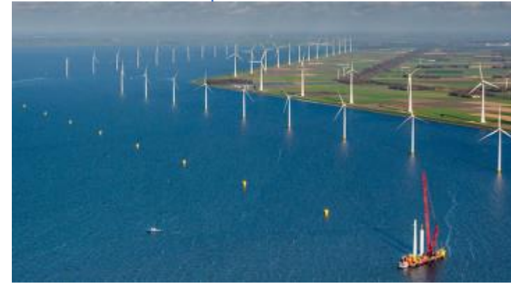
海底ケーブルの設置
