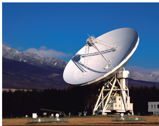
国立天文台野辺山宇宙電波観測所の45m電波望遠鏡（電波を集めるパラボラの直径が45mある） 写真は国立天文台提供
