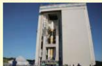
大型ロケット組立棟 (VAB)
