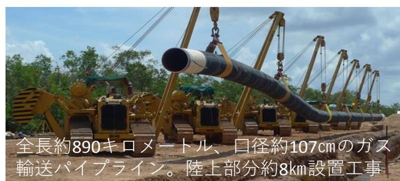
全長約890キロメートル、口径約107cmのガス輸送パイプライン。陸上部分約8km設置工事
